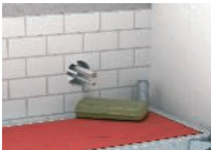
Minerální vlna s bodem tání \geq 1000 °C, určená k ucpání otvoru
