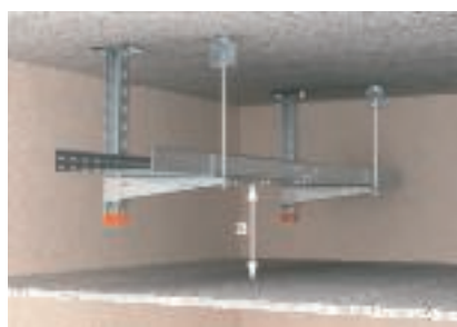
Potřebná minimální vzdálenost od protipožárního podhledu
