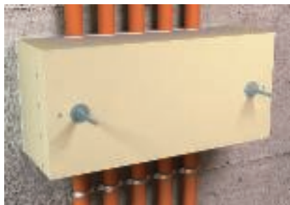
Montáž odlehčení tahu v kombinaci s ukládáním pomocí jednotlivých příchytok
