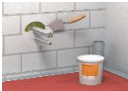
Oboustranné uzavření povrchu do hloubky 2 cm pomocí intumescentní hmoty DSX
