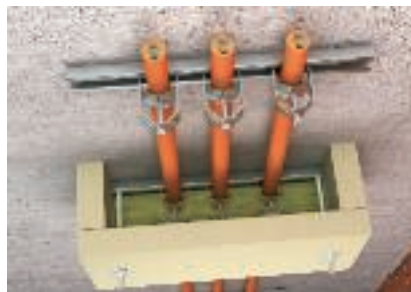
Montáž odlehčení tahu v kombinaci s uložením kabelů na profilové lišty
