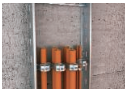
Upevnění jednotlivých kabelů nebo kabelů ve svazku pomocí třmenových přichytek
