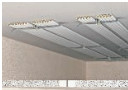
Montáž na strop nad zavěšeným protipožárním podhledem
