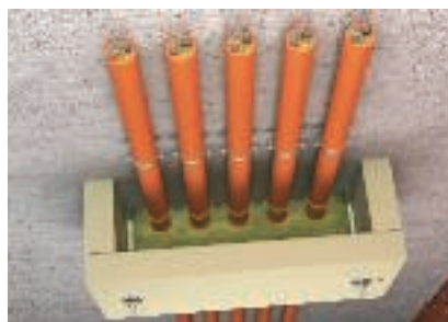
Účinné podepření pomocí odlehčení tahu ZSE90
