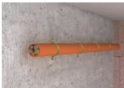
Vodorovná montáž kabelů na stěnu
