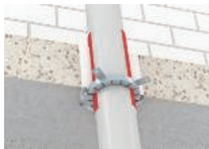
Montáž na spodní stranu stropu pomocí kovových kotev
