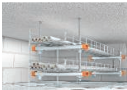
Montáž na strop ve dvou vrstvách nad zavěšeným protipožárním podhledem
