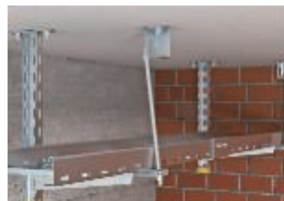
Zavěšení závitové tyče do protipožárního třmenu
