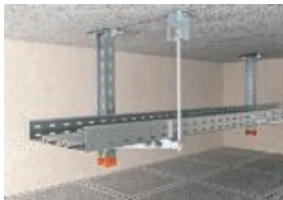
Zavěšení na strop v jedné vrstvě
