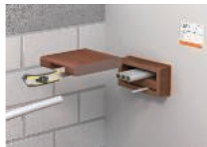
Přesné zařiznutí vnitřních dílů a vložení do rámu
