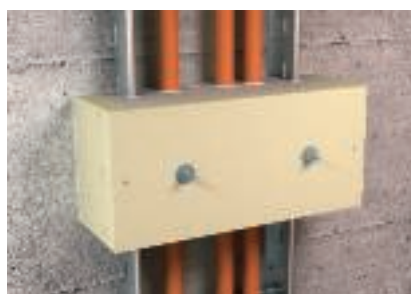
Účinné podepření pomocí odlehčení tahu ZSE90
