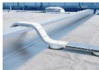
Použití na fotovoltaických vedeních vedených přes požární stěnu
