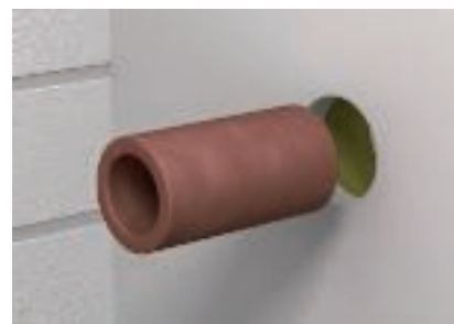
Vložení obalové trubky do lehké přepážky
