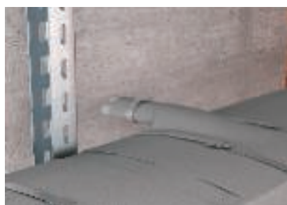
Výstup kabelů opatřených bandážemi
