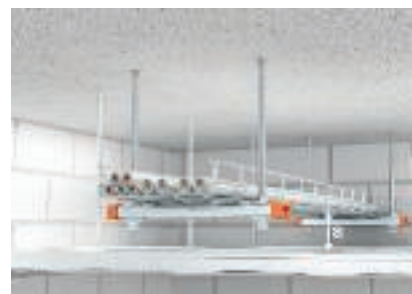
Potřebná minimální vzdálenost od protipožárního podhledu
