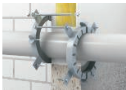
Excentrické uspořádání s trubkovými manžetami většími o maximálně 3 velikosti
