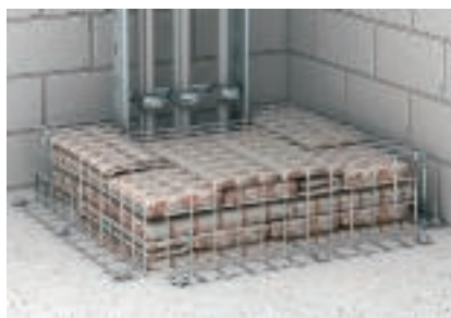
Zabezpečení proti sklouznutí nad podlahou
