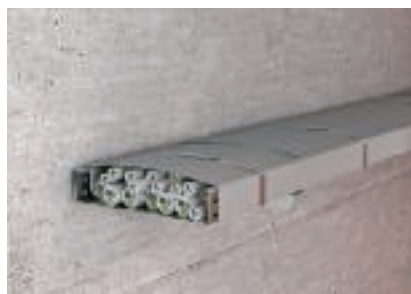
Úplné ovinutí kabelové trasy namontované na stěně
