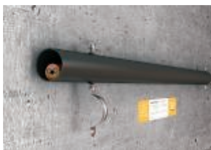
Vložení do šroubovací distanční příchytky zaháknutím vrchního dílu pod šroub
