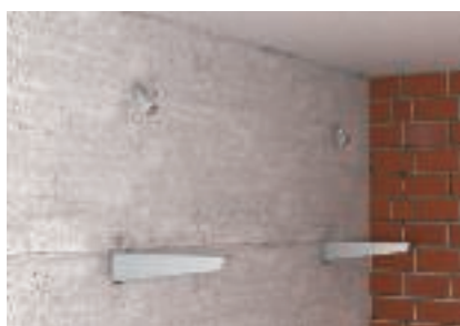
Montáž výložníků a přípojovacích konstrukčních dílů na stěnu
