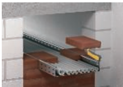
Montáž bloků zaříznutých na požřebnou velikost
