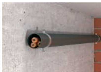
Instalace více kabelů dle údajů uvedených ve zkušebních osvědčeních
