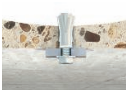
Kotva do dutých stropů typu FHY
