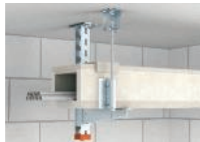
Montáž v podobě kanálu E s dodatečným zajištěním závitovými tyčemi
