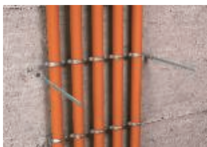
Upevňovací body vedle kabelů přímo na stěně
