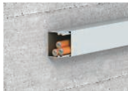
Estetické uložení datových kabelů a kabelů požární signalizace do kanálu typu 20030
