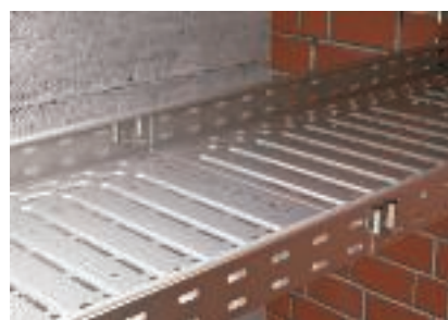
Spojení míst styku bez dodatečného sešroubování
