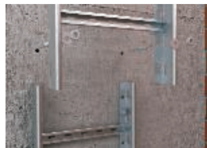
Zhotovení místa styku beze spojky
