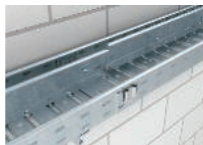
Montáž přepážky pomocí šroubů s plochou kulovou hlavou
