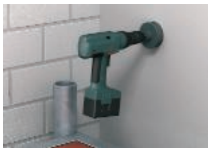
Vyvrtní otvoru pomocí jádrového vrtáku
