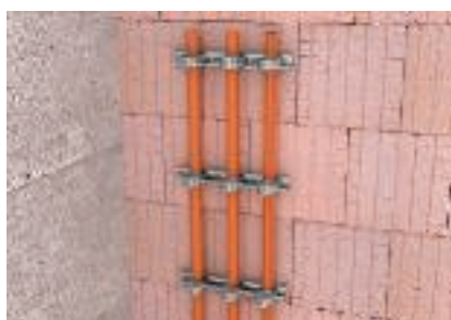
Svislá montáž kabelů na stěnu pomocí třmenových příchyttek
