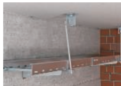
Upevnění závitových tyčí na strop pomocí protipožárního třmenu
