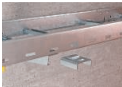
Nasunutí přípojovacího konstrukčního dílu na dolní pás bočnice žebříku
