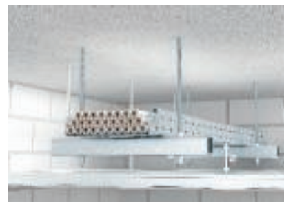
Potřebná minimální vzdálenost od protipožárního podhledu
