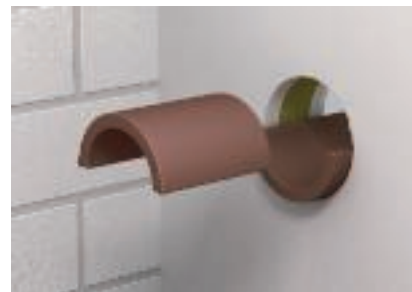
Montáž obalové trubky do lehké přepážky
