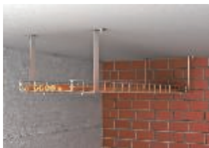
Jednovrstvá montáž se závěsným úhelníkem na strop
