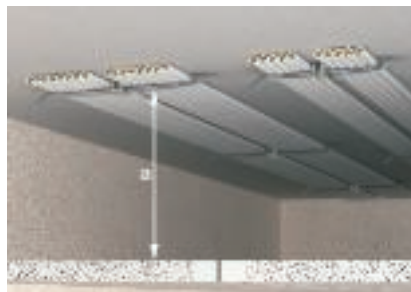
Potřebná minimální vzdálenost od protipožárního podhledu
