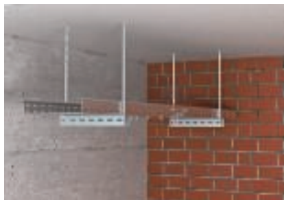
Zavěšení na strop v jedné vrstvě
