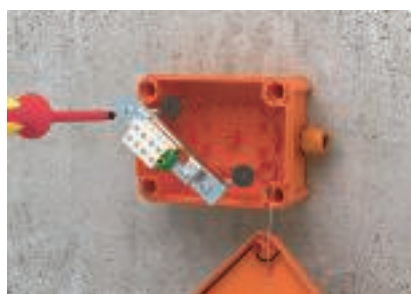
Montáž s protipožární šroubovou kotvou prostřednictvím třmenu a dna krabice FireBox
