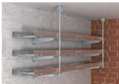
Montáž na stěnu ve více vrstvách se svislým zajištěním závitovými tyčemi
