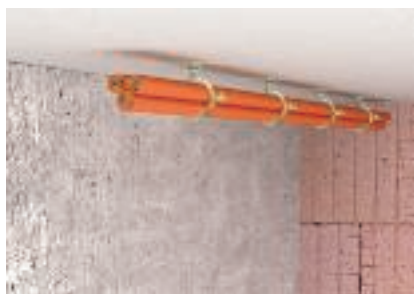
Uložení svazku kabelů pod strop
