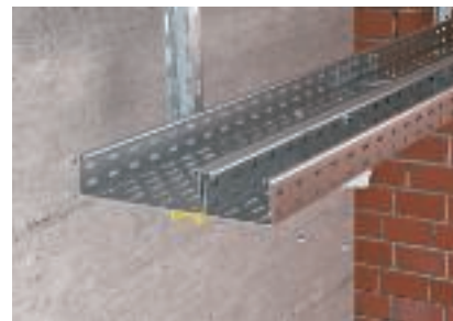
Montáž dvou kabelových žlabů společně na jeden výložník
