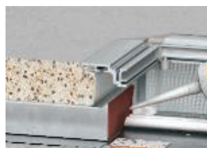
Uzavření spár mezi kabely a bloky stěrkovou hmotou FBA-SP
