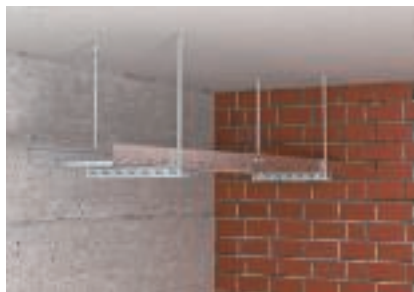
Zavěšení na strop v jedné vrstvě
