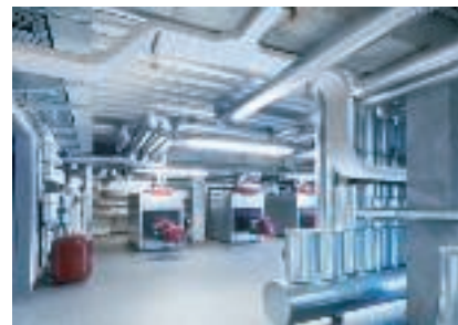
Použití na nosných systémech v zásobovacích místnostech nebo výrobních halách
