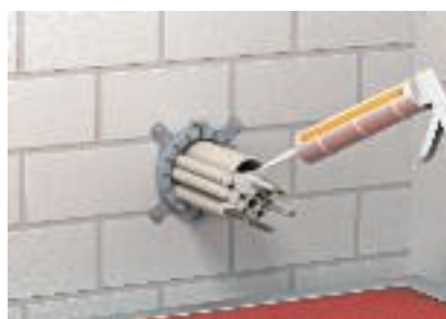
Uzavření konců trubek intumescentní hmotou DSX
