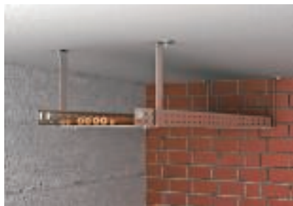
Jednovrstvá montáž se závěsným úhelníkem na strop
