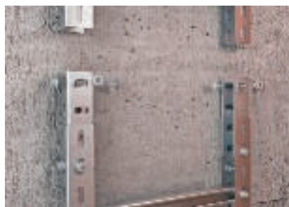
Zhotovení místa styku pomocí přišroubované spojky
