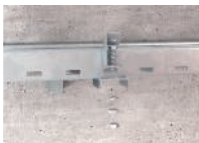
Montáž šikmého přípojovacího konstrukčního dílu pomocí šestihranného šroubu a šestihranných matic
