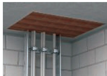
Těsná vestavba bloků do prostupu stropem
