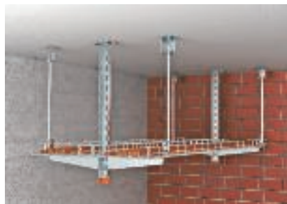
Montáž na strop pomocí výložníků umístěných po obou stranách
