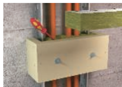
Plnivo z minerální vlny pro flexibilní osazení kabelů
