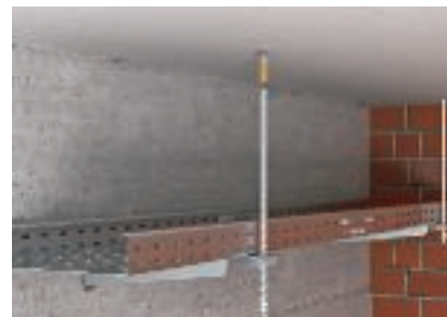
Upevnění závitových tyčí na strop pomocí kotev s vnitřním závitem
