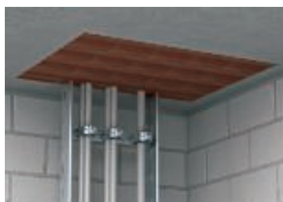
Těsná vestavba bloků do prostupu stropem
