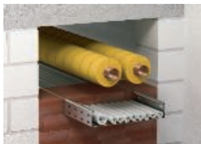
Protažené nehořlavé trubky s izolační trasy
