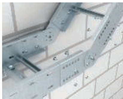
Svislé kloubové spojení pro velká rozpětí Svislé úhlové spojení kabelových žebříků pro velká rozpětí pomocí kloubové spojky typu WRGV.
