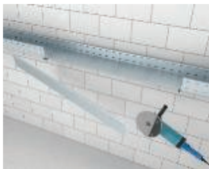
Zhotovení odbočného dílu T pomocí rohového vestavného dílu Přerušení bočnice na probíhající žlabu pro velká rozpětí.
