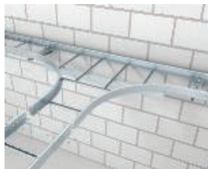
Montáž odbočného dílu T Montáž odbočného dílu T typu LT pro zhotovení vodorovného výstupu. V místě tvarových dílů by měly být použity další podpěry.
