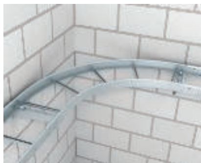
Montáž oblouků kabelových žebříků Spojení kabelových žebříků s oblouky typu LBI 90. V místě tvarových dílů by měly být použity další podpěry.
