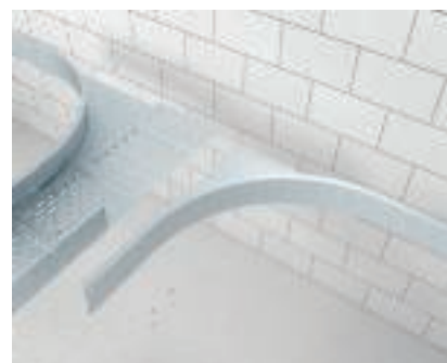
Zhotovení odbočného dílu T pomocí rohového vestavného dílu Montáž druhého rohového vestavného dílu typu WEAS 110.
