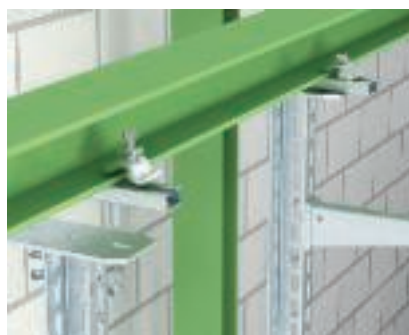
Krakorec z profilu C na ocelovém nosníku Použití dodatečné profilové lišty C typu CPS u širokých ocelových nosníků. Průběh trasy podélně vůči ocelovému nosníku.
