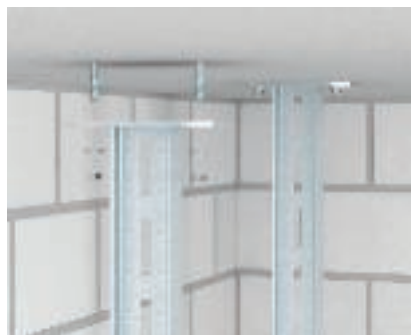
Závěsná konstrukce v betonu Závěsná konstrukce vhodná pro systém pro velká rozpětí upevněná v betonu pomocí profilu IS 8 a kotev.
