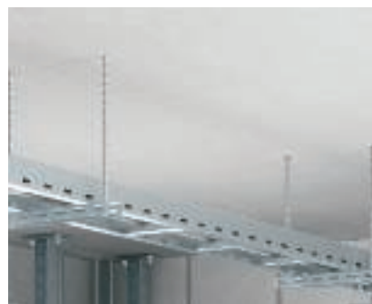
Použití zavěšení na závitové tyče Zavěšení kabelového žebříku pomocí závitových tyčí a profilů U jako příčného profilu.
