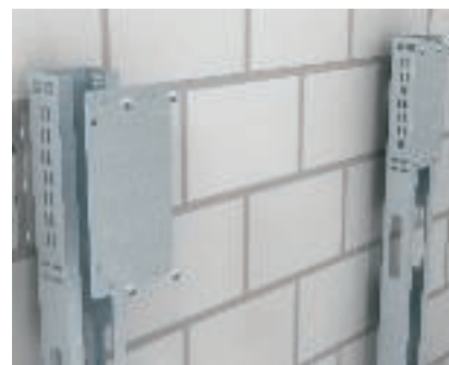
Montáž přístrojové desky Montáž přístrojové desky typu GP na připojovací motorový sloup.
