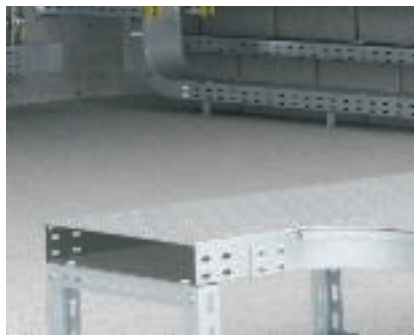
Použití pochozího systému kabelových žlabů Pochozí systém kabelových žlabů, podepřený konstrukcí z profilů U.
