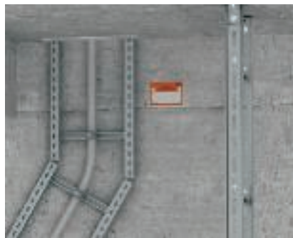
Realizace změny směru Realizace změny směru u těžkého stoupacího žebříku typu SLM.
