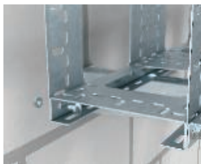
Montáž profilu dna Montáž profilu dna v systému BKK.
