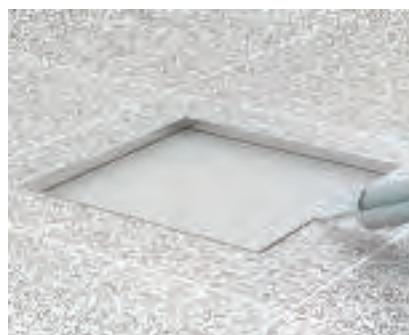
Položení podlahové krytiny ke kazetovému rámu Osadte podlahovou krytinu ke kazetovému rámu. Zbývající mezeru mezi podlahovou krytinou a kazetovým rámem utěsněte vhodnými materiály.
