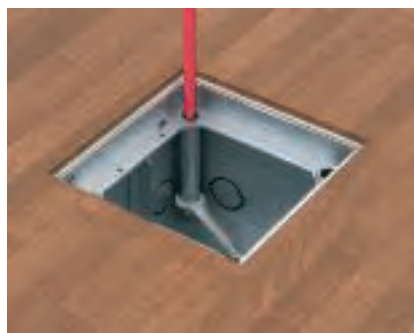
Nastavení na horní hranu hotové podlahy Provedte výškové nastavení a zajistěte nivelační šrouby kontramaticí.
