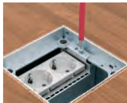
Upevnění nosiče zásuvek Vložte a upevněte kovový nosič do GE2V.
