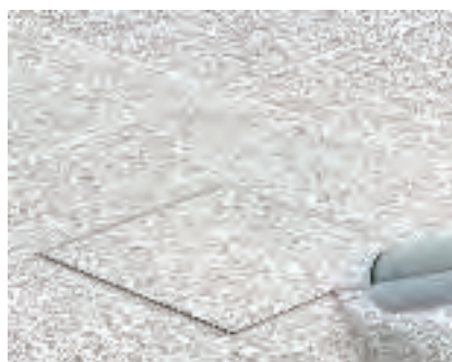
Uložení podlahové krytiny do kazety RKN Vložte podlahovou krytinu do kazety a přilepte ji. Zbývající mezeru mezi podlahovou krytinou a kazetou utěsňte vhodnými materiály.
