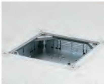
Příprava podlahového systému Čtyři podpěry víka pro vysoká zatížení vložte do rohů podlahové krabice a nastavte je na potřebnou výšku. Opěrný šroub zajistěte kontramaticí.
