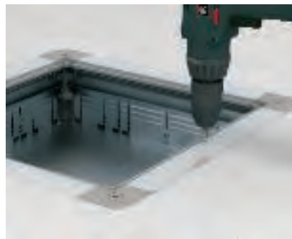
Upevnění kazetového rámu na podlahovou krabici Na označených místech vyvrtejte upevňovací otvory (Ø 3 mm) pro kazetový rám.
