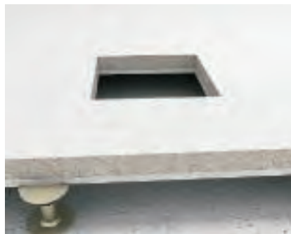
Příprava montáže Montážní prostor pro kazetu musí být kompletně zhotovený a čistý.
