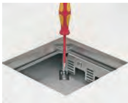
Montáž kazety Nivelační jednotky kazety upevněte na nosný strop.
